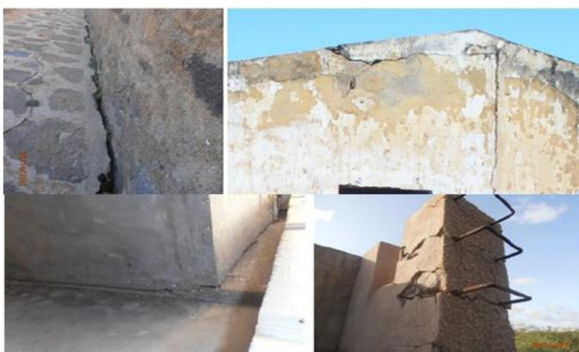
Figura 12: As consequências do assentamento em pavimentos de alvenaria. Tirada da Monografia de Luís Gomes Semedo – Reabilitação Urbana – Uma proposta para Campo de Concentração do Tarrafal.
