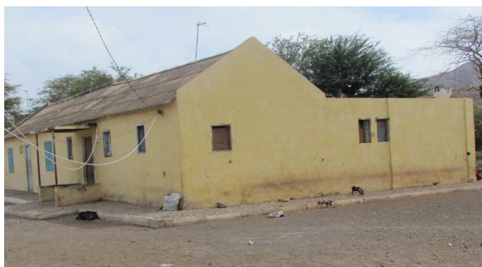
Figura 14. Moradias dos motoristas.
