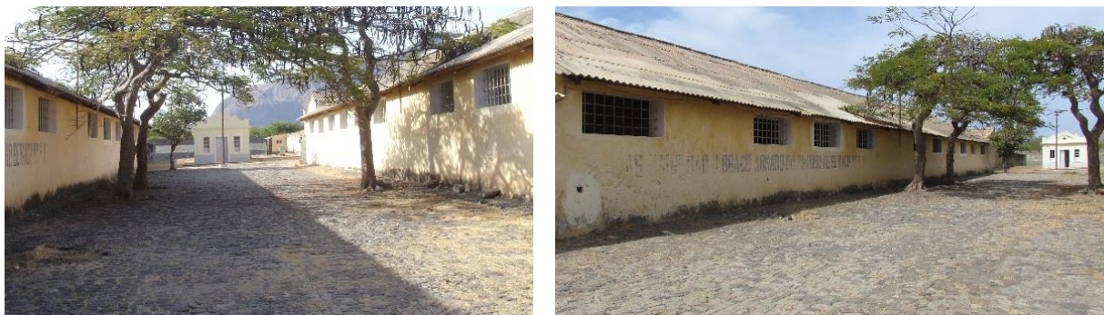
Figura 28.. Aspectos da alameda central, com os pavilhões onde se situavam as celas dos presos.
