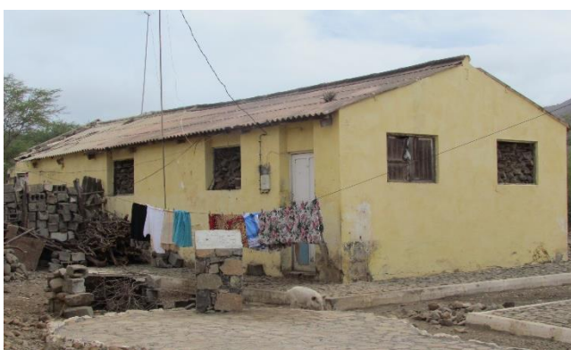
Ficha 9 Refeitório e salas dos soldados
