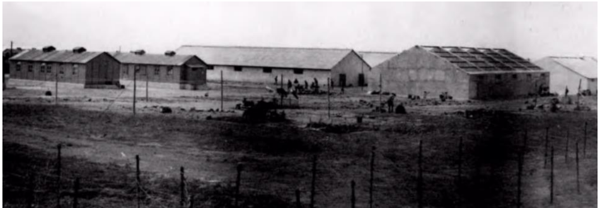
Figura 44. Imagem da 2ª fase, durante a construção. Fonte: Imagem “Arquivo Histórico Nacional Cabo Verde”
