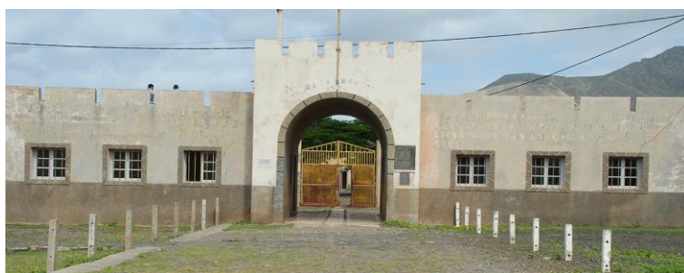
Figura 26. Casas dos guardas.
