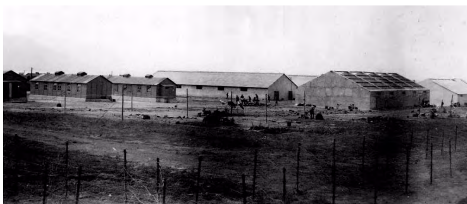
FIGURA 28. A COLÓNIA PENAL DO TARRAFAL EM CONSTRUÇÃO
