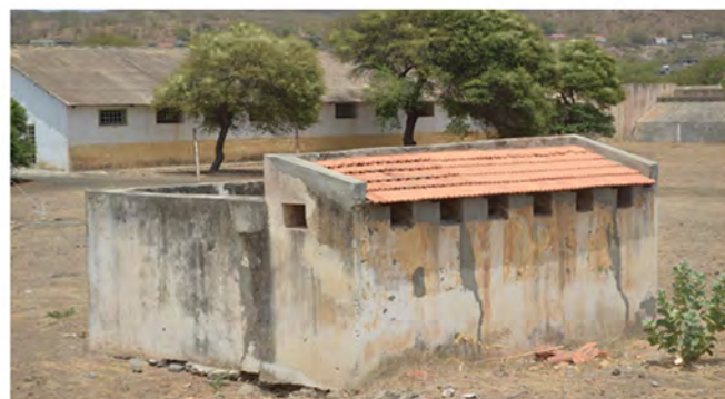
Sanitario dos Caboverdeanos
