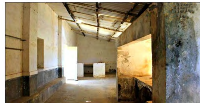
Interior da Cozinha
